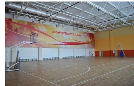
Спортивные залы пролетом до 30 метров могут быть перекрыты типовым решением «Молодечно». Большие пролеты также возможно перекрывать конструктивными системами из ГСП и листового проката, пример - спортивный дворец для хоккея с мячом в г. Хабаровске.
