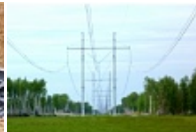
ВЛ 200 кВ Краснодарская ГРЭС- Нижний Небоход. Опора 2МН1500-1В (вес 33 т, высота 33,2 м)
