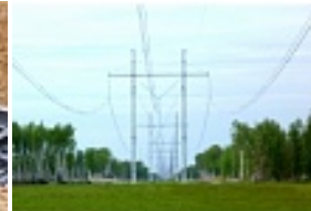
ВЛ 200 кВ Краснодарская ГРЭС- Нижний Небоход. Опора 2МН1500-1В (бес 33 м, высота 33,2 м)
