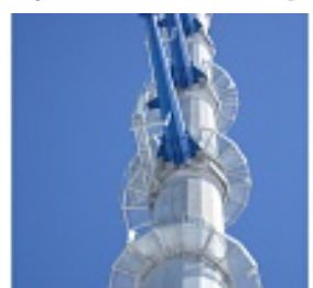
ВЛ 220 кВ Орбита-Спутник. Опоры АУМ 220-2В (вес 9,5 т, высота 60,5 м)
