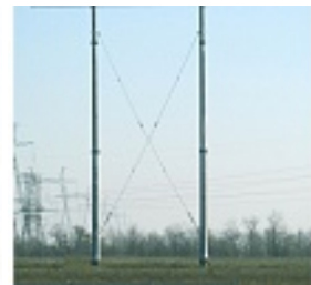
ВЛ 220 кВ Орбита-Спутник. 1.220-2В-3В (бес 24,3 м, высота 43,4
