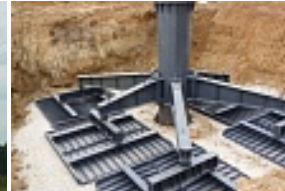
ВЛ 220 кВ Орбита-Спутник. элемент ФПМ220-2В-1В (бес 34,8
