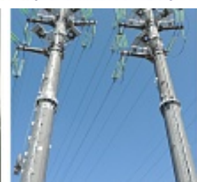
ВЛ 200 кВ Краснодарская ГРЭС- Нижний Небоход. Опора 2МН1500-1В (вес 33 т, высота 33,2 м)
