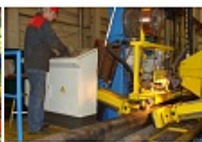
Автоматическая сборка-сварка под флюсом
