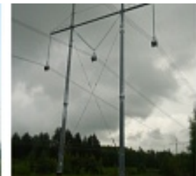
ВЛ 220 кВ Орбита-Спутник. элемент ФПМ220-2В-1В (бес 34,8
