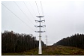
ВЛ 220 кВ Орбита-Спутник. Опоры АУМ 220-2В (вес 9,5 т, высота 60,5 м)
