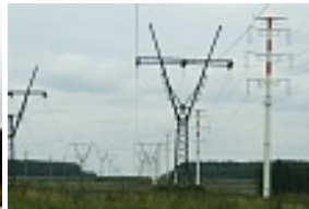
ВЛ 220 кВ Орбита-Спутник. 1.220-2В-3В (вес 24,3 т, высота 43,4
