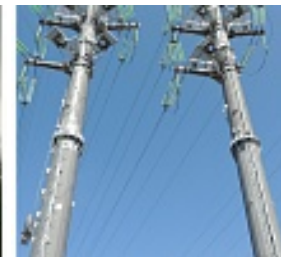
ВЛ 200 кВ Краснодарская ГРЭС- Нижний Небоход. Опора 2МН1500-1В (бес 33 м, высота 33,2 м)
