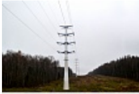
ВЛ 220 кВ Орбита-Спутник. Опоры АУМ 220-2В (бес 9,5 м, высота 60,5 м)
