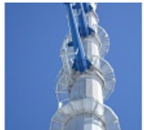
ВЛ 220 кВ Орбита-Спутник. Опоры АУМ 220-2В (бес 9,5 м, высота 60,5 м)
