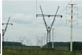
ВЛ 220 кВ Орбита-Спутник. 1.220-2В-3В (бес 24,3 м, высота 43,4
