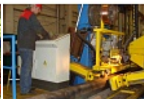
Автоматическая сборка-сварка под флюсом
