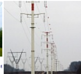
ВЛ 200 кВ Краснодарская ГРЭС- Нижний Небоход. Опора 2МН1500-1В (вес 33 т, высота 33,2 м)
