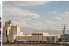
Производственный здание 25,0х21,0х8,2 м, Республика Удмуртия, Тавантуйский обл.
