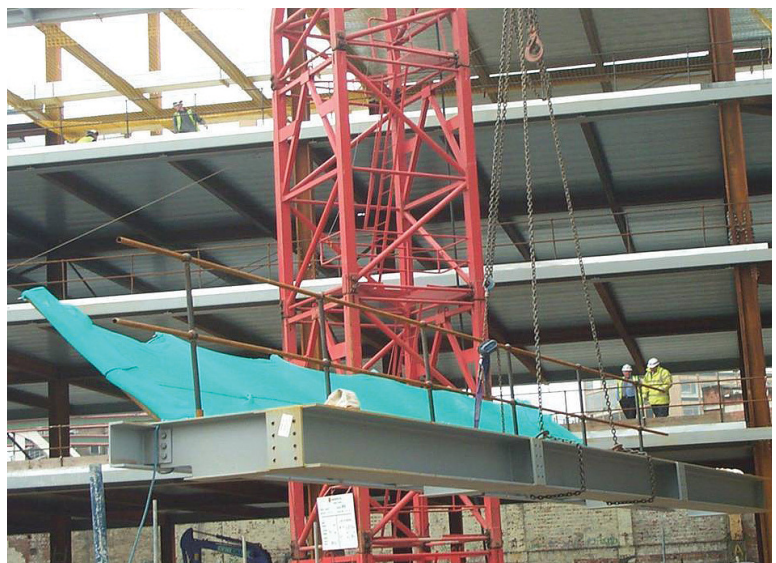
Фасадная сетка, закрепленная на балке перед подъемом
