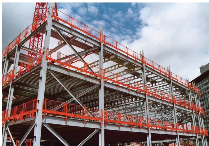
Стальной каркас, подготовленный для передачи Генеральному подрядчику
