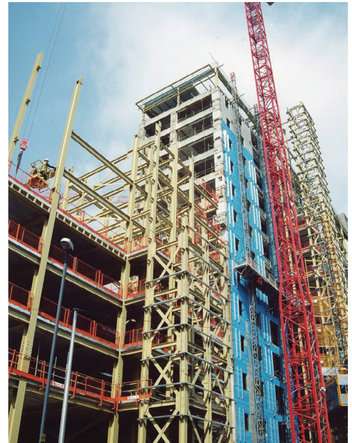
Подъемная платформа, установленная на перекрытии
