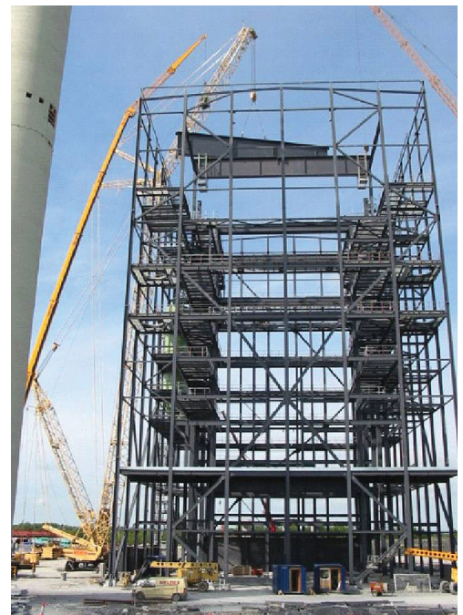
Рабочая платформа, установленная на балках верхнего этажа
