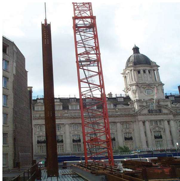
Крепление колонны замком Дюсона
