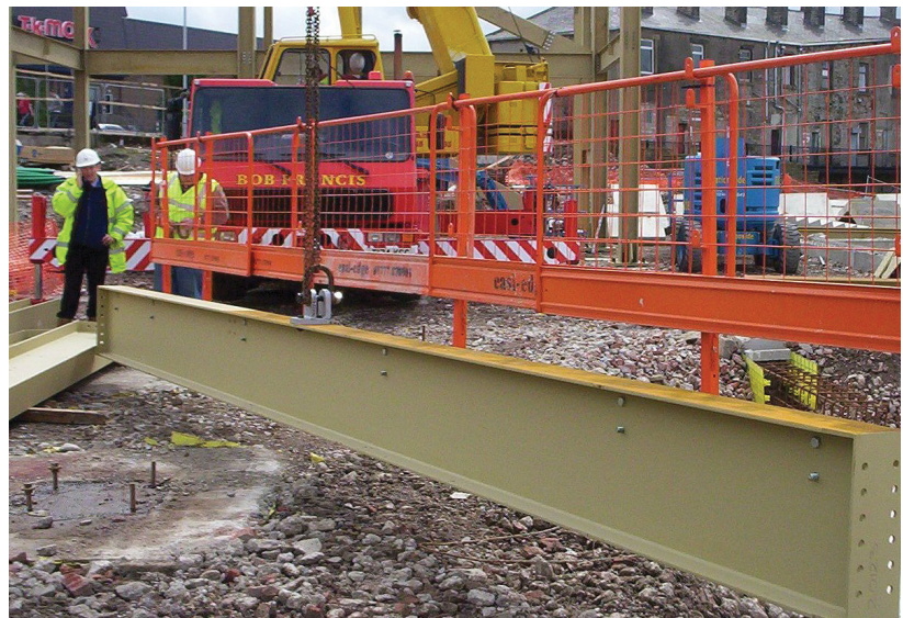
Фасадная сетка, закрепленная на балке перед подъемом
