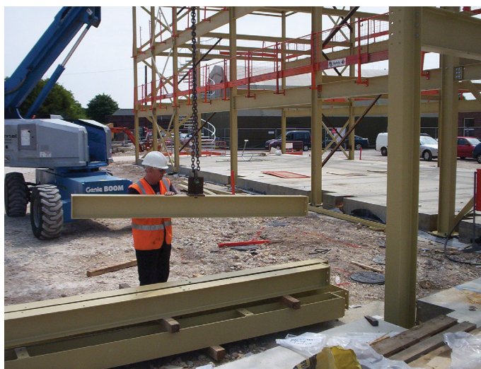
Подъем элемента конструкции с помощью монтажных скоб
