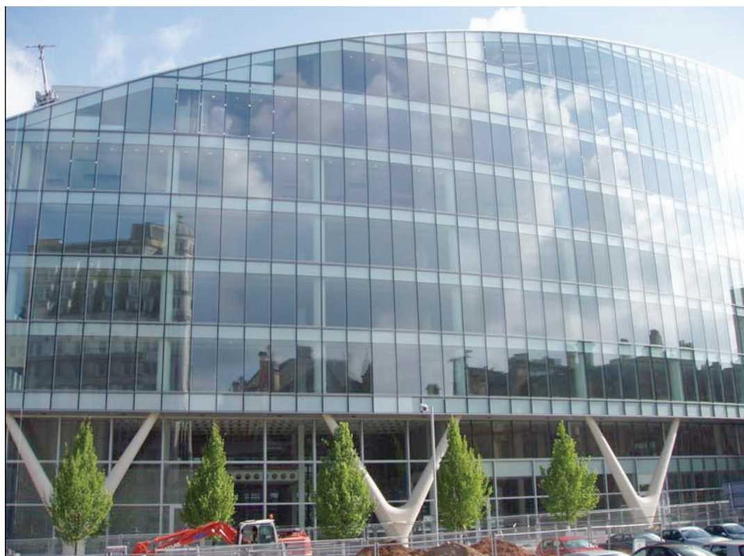
Рисунок 25 Фасадная стена с тройными стеклопакетами
