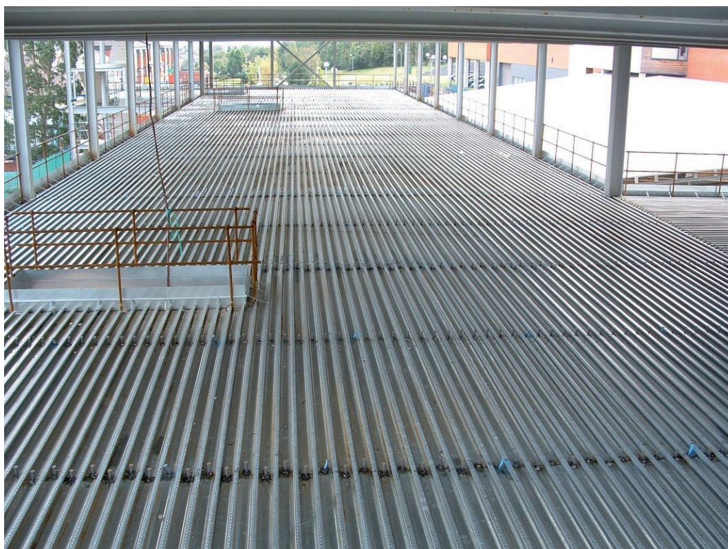
Рисунок 1 Уложенный профилированный настил создаёт удобную площадку для выполнения монтажных работ
