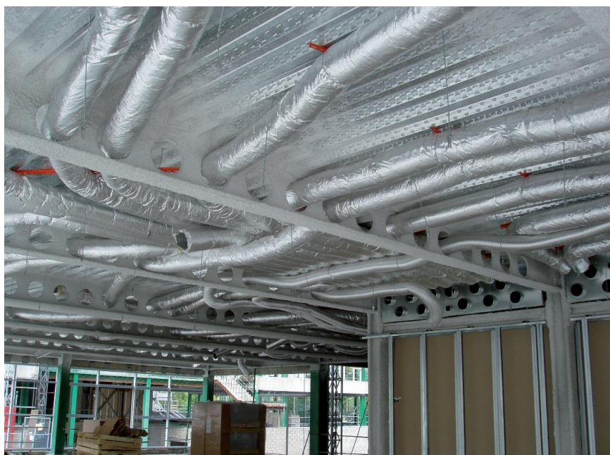
Рисунок 2 Размещение трубопровода инженерных систем в объёме перекрытия
