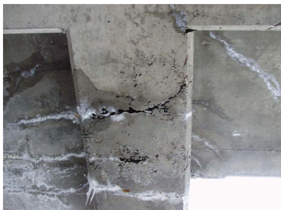
Рис. 11. Дефекты железобетонных конструкций НМРА
