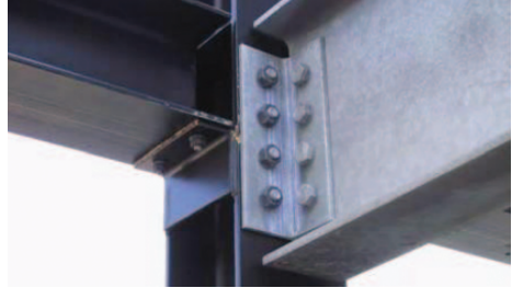
Рис. 5б. Простые балочно-стоечные болтовые сопряжения с использованием уголковых креплений
