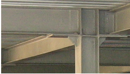
Рис. 5а. Сварные балочно-стоечные сопряжения
